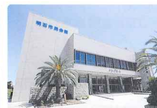
アワーズホール・明石市立市民会館
